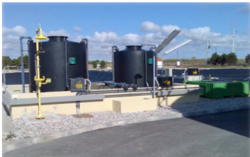
Depósitos de armazenagem em retenção clássica de betão: possibilidade de acessórios laterais sem restrições.
