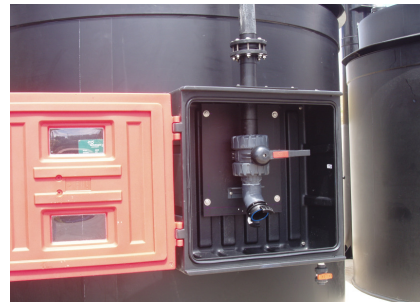
Armário de carga em PEAD: Válvula e raccord protegidos.
