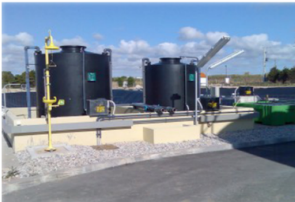
Depósitos de armazenagem em retenção clássica de betão: possibilidade de acessórios laterais sem restrições
